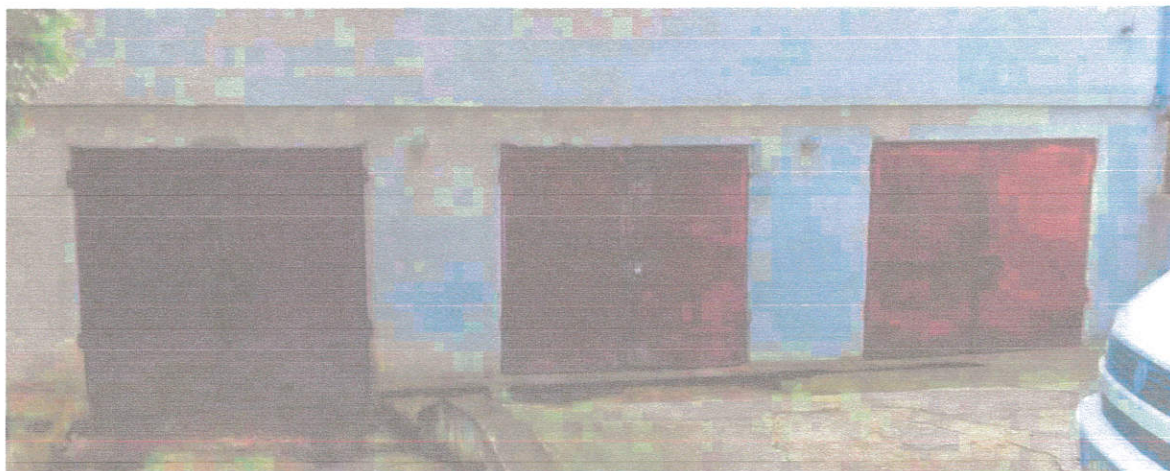
fot. 4 Istniejąca stolarka drzwiowa
