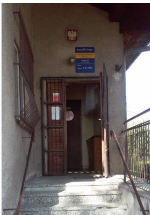
fot. 3 Istniejąca stolarka drzwiowa
