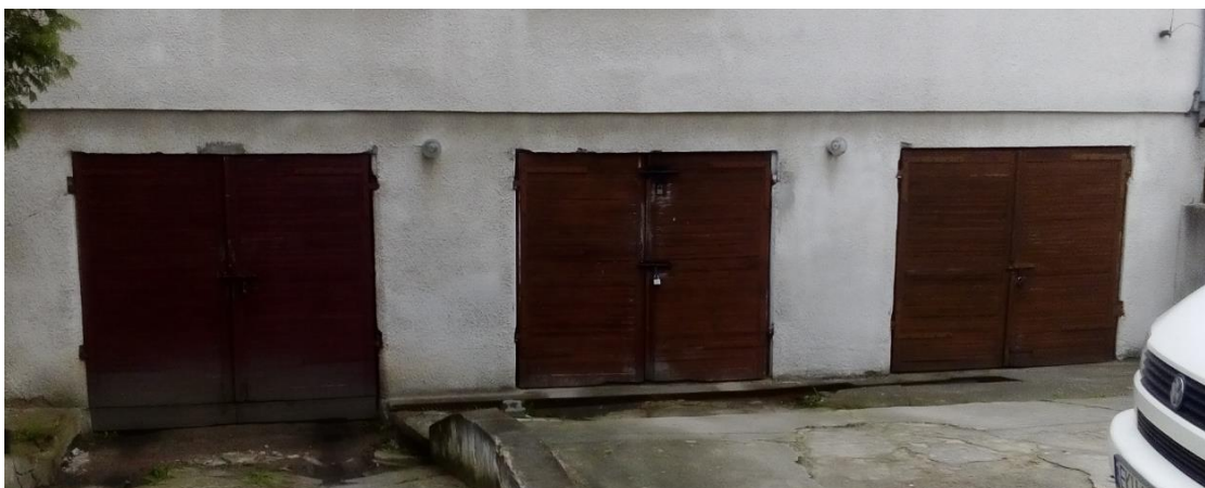
fot. 4 Istniejąca stolarka drzwiowa
