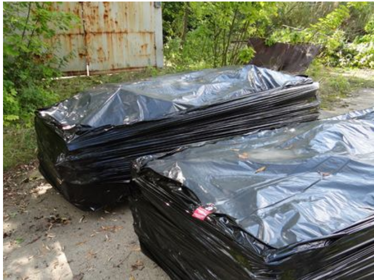
Rys. nr 6. Zabezpieczanie zdjętych płyt azbestowo – cementowych przed transportem na składowisko.
